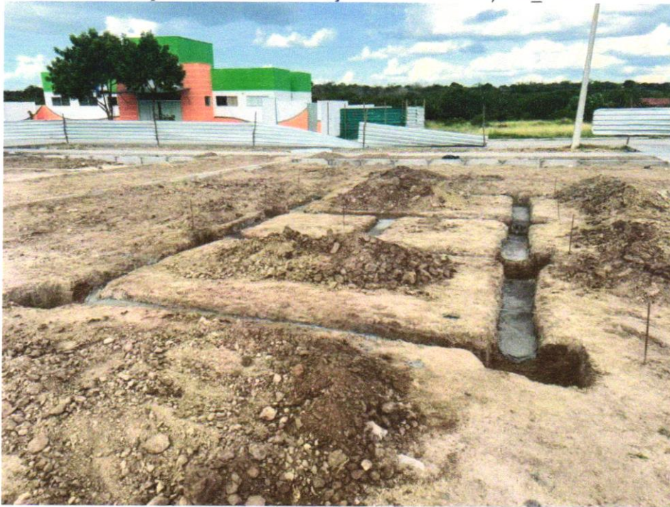
Foto 04 - ESCAVAÇÃO MANUAL PARA BLOCO DE COROAMENTO OU SAPATA (INCLUINDO ESCAVAÇÃO PARA COLOCAÇÃO DE FÔRMAS). AF_06/2017
