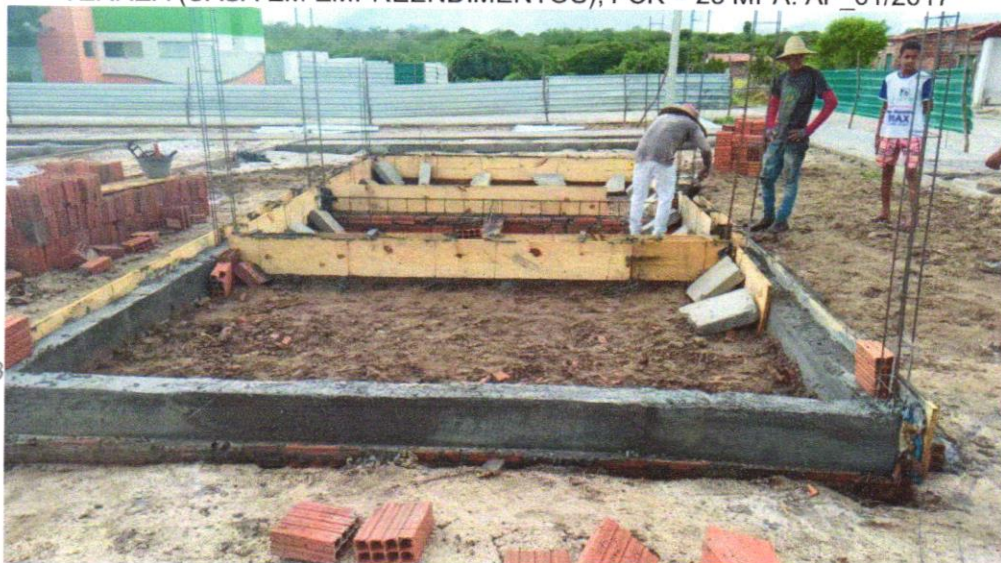
Foto 06 - COMPOSIÇÃO REPRESENTATIVA) EXECUÇÃO DE ESTRUTURAS DE CONCRETO ARMADO, PARA EDIFICAÇÃO HABITACIONAL UNIFAMILIAR TÉRREA (CASA EM EMPREENDIMENTOS), FCK = 25 MPA. AF_01/2017
