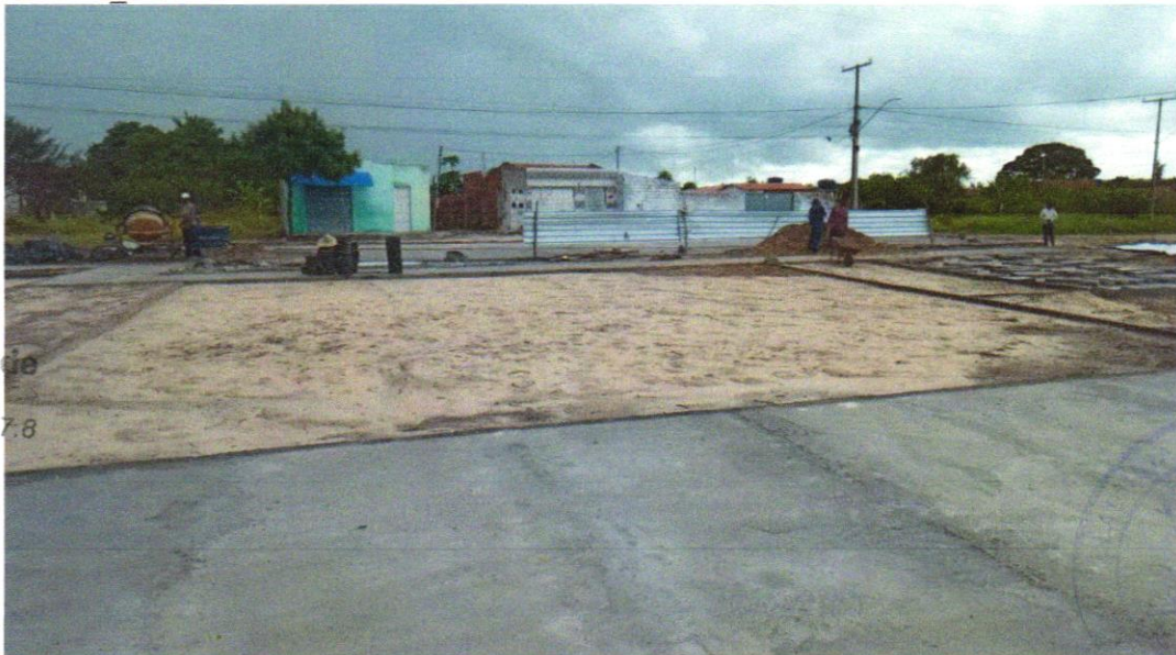
Foto 02 - REGULARIZAÇÃO E COMPACTAÇÃO DE SUBLEITO DE SOLO PREDOMINANTEMENTE ARENOSO. AF_11/2019
